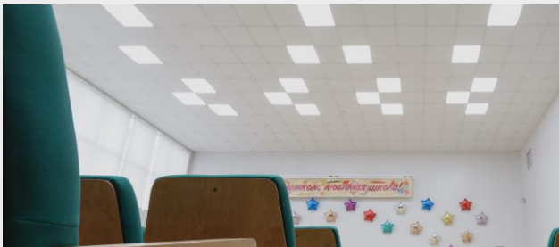
ОСВЕЩЕНИЕ ДЛЯ МУНИЦИПАЛЬНЫХ ОБЪЕКТОВ
